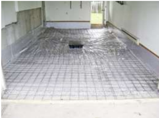
10. Pose du polyéthylène et pose du treillis
