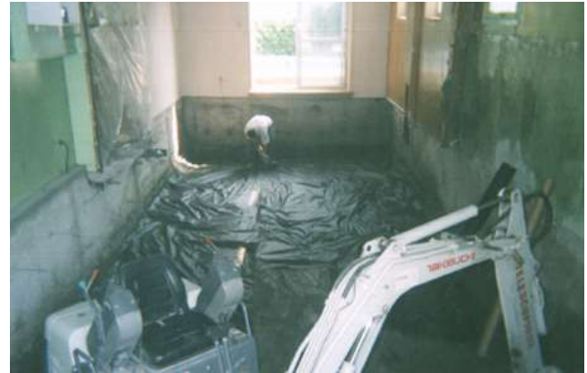
4. Excavation finale et pose du géotextile.
