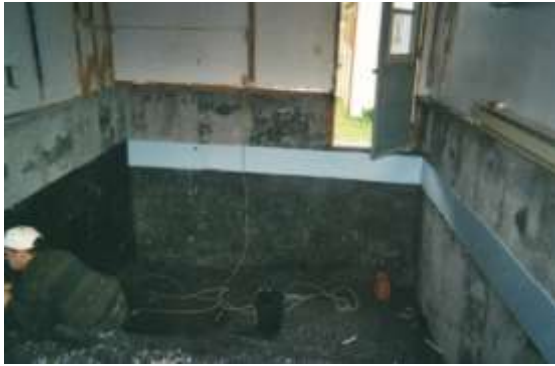
7. Pose du joint d'expansion au pourtour de la dalle
