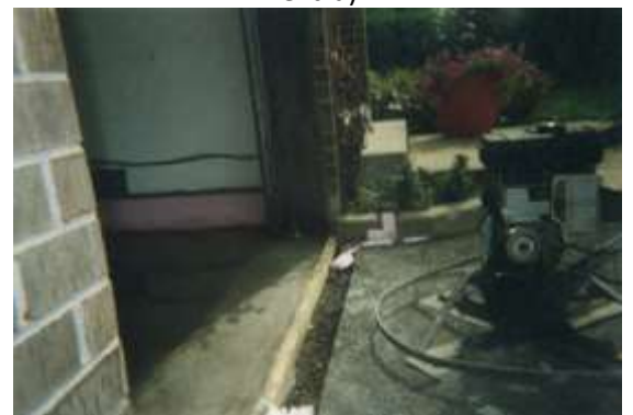
13. La dalle est égal au dessus de la fondation (à l'épreuve de la pousse par le gel) pavage ou pavé sera ajusté
