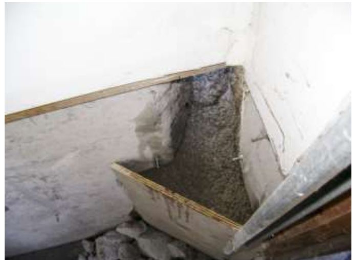
Coulée d'un coin de béton
