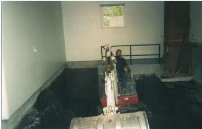
3. Excavation de la pyrite
