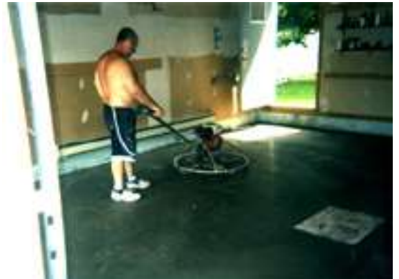
11. Finition de la dalle à la main (hélicoptère en extra)
