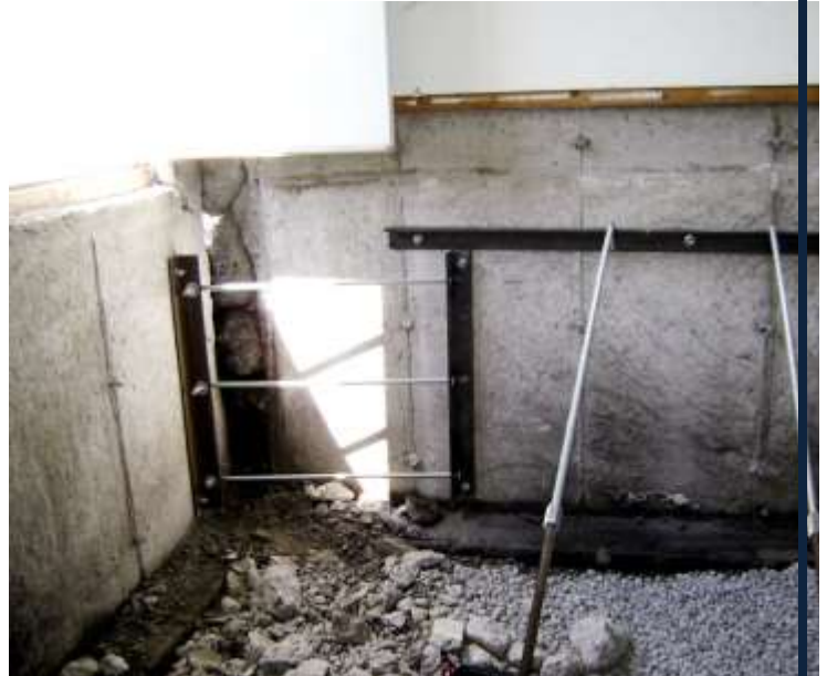
Coulée d'un coin de béton
