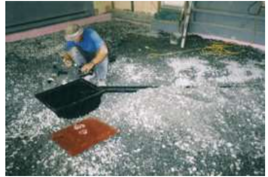
8. Pose du nouveau puisard et de la plomberie
