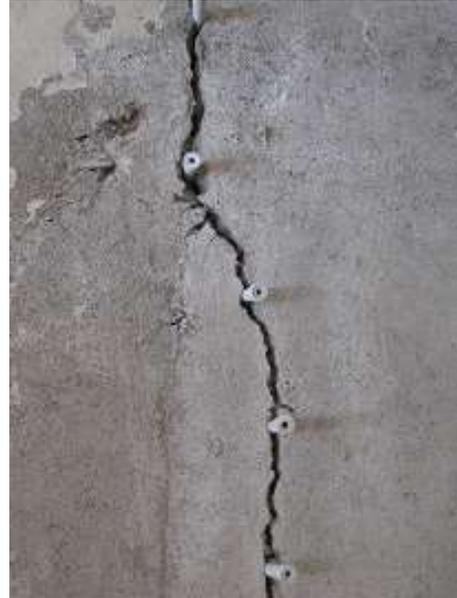
2. Après le nettoyage de la fissure, nous installons des douilles d'injection. Ces douilles permettront d'injecter l'époxy/polymère dans la fissure. Il existe plusieurs types d'injection.
