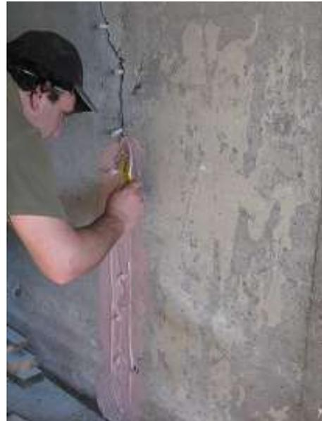
4. Nous installons la pâte permettant de colmater la fissure et le pourtour des douilles d'injection.
