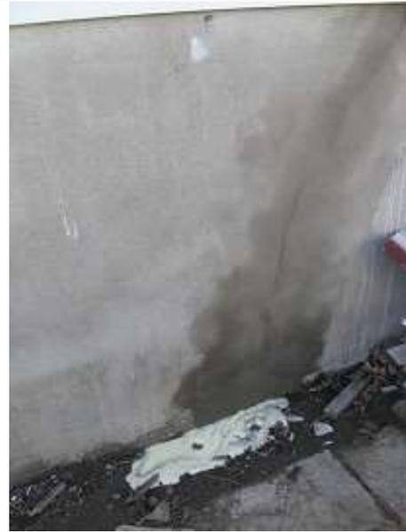
10. Le produit à traverser l'épaisseur du mur de fondation et est sorti à l'extérieur. Ceci démontre que l'épaisseur du mur de fondation s'est remplie de produit d'injection.
