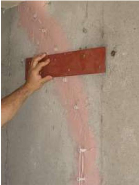
5. Nous installons des plaques d'acier si besoin il y a.
